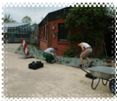
Anlegen der Kiesbeete am neuen Hauptweg
